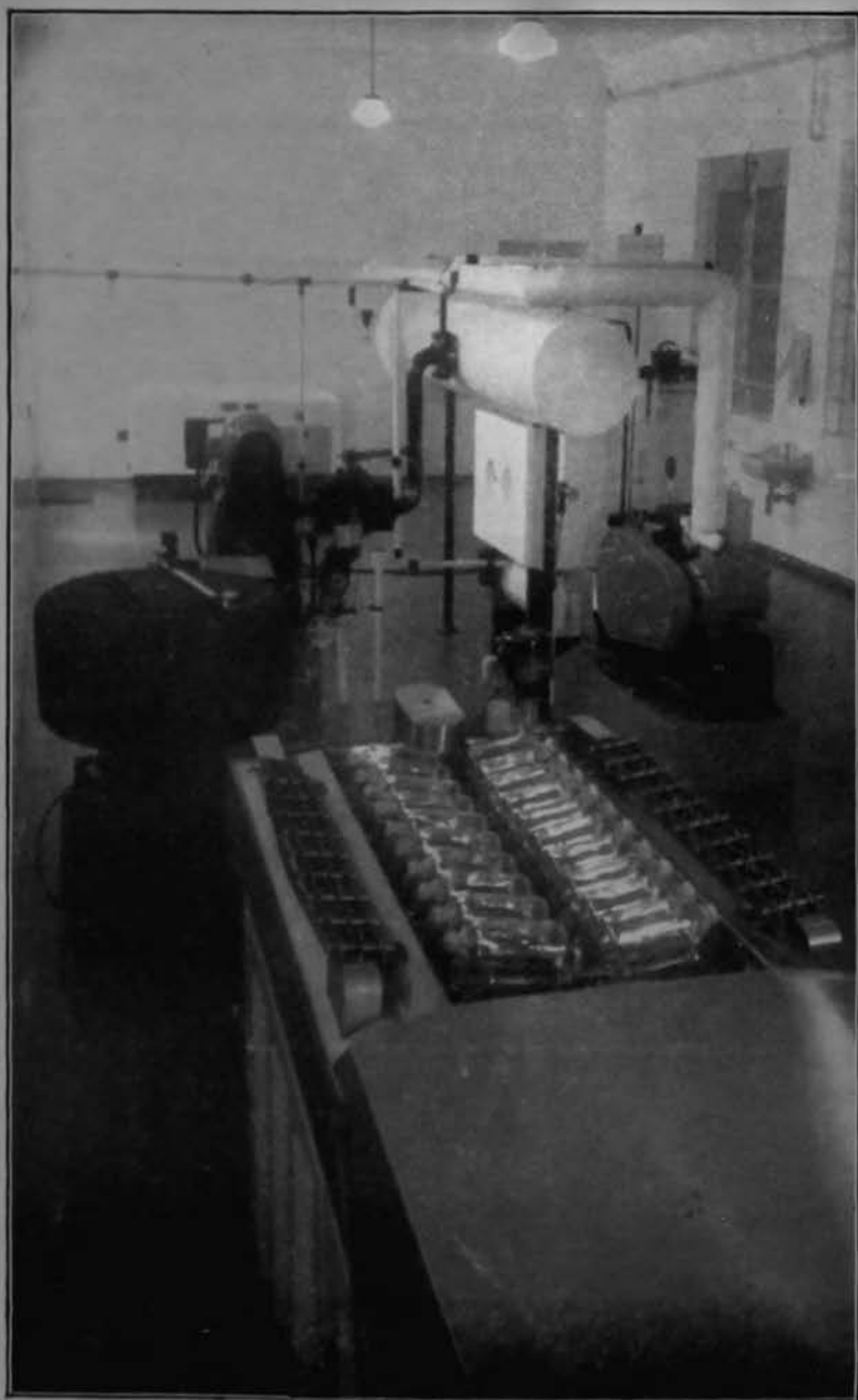
Foto 11 Instalação de Liofilização.
