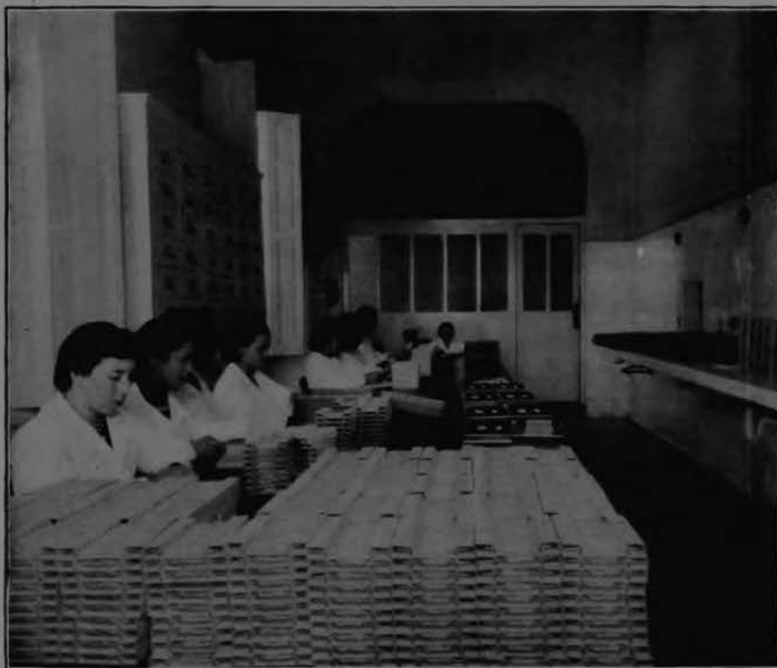
Sala de acondicionamento de produtos.
